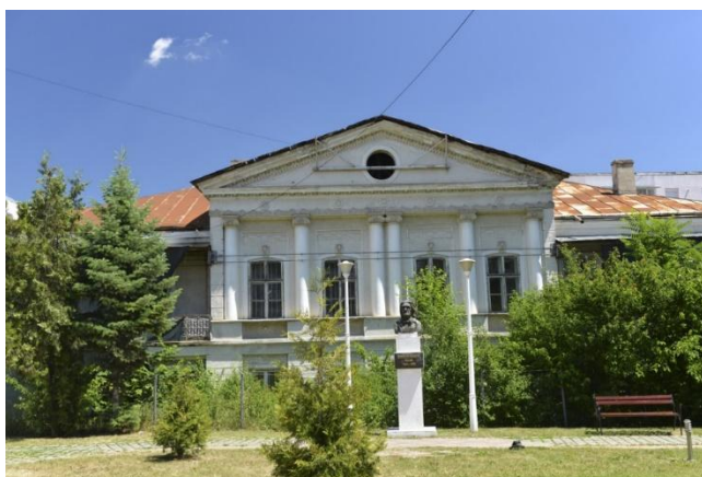
Fotografie 6 - Casa vornicului Done - Casa Sergiu Celibidache
