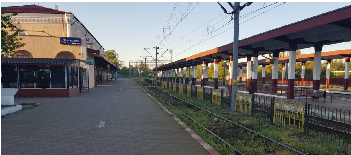
Figură 71 - Imagine reprezentativă cu zona peroanelor gării Roman, sură: Foto consultant
