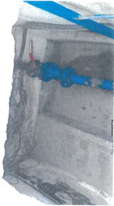
Foto 26: Vedere interioară puț P61.
