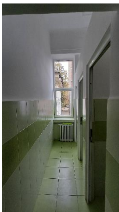
Instalația sanitară existentă
