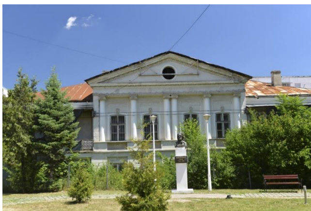
Fotografie 6 - Casa vornicului Done - Casa Sergiu Celibidache
