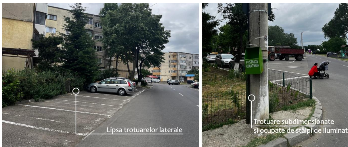
Figură 11 - Strada Victor Hugo – Lipsa infrastructurii pentru deplasări nemotorizate
