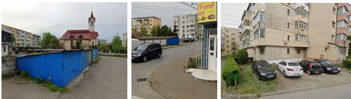
Figură 9 - Imagini reprezentative - Strada Alexandru cel Bun (borduri impracticabile pentru persoane cu mobilitate redusă, garaje individuale, staționare/parcare pe spații verzi și lipsa trotuarelor)
