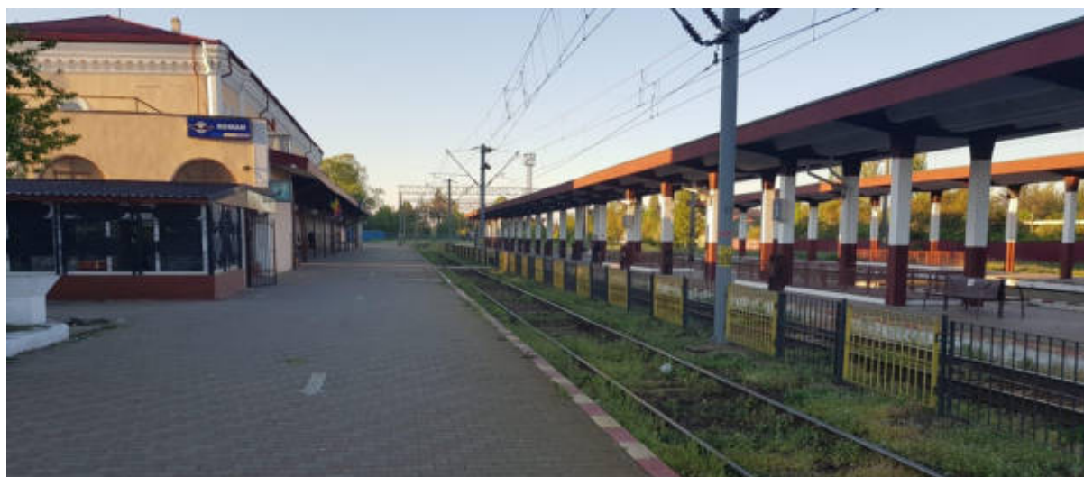
Figură 64 - Imagine reprezentativă cu zona peroanelor gării Roman, sursă: Foto consultant
