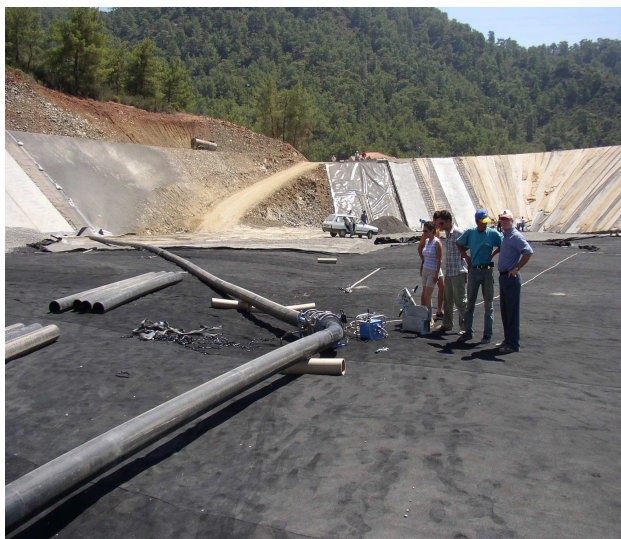
Figura 11: Construcția unui depozit de deseuri
